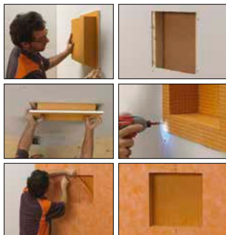
Zabudowa w płyty gipsowo-kartonowe
